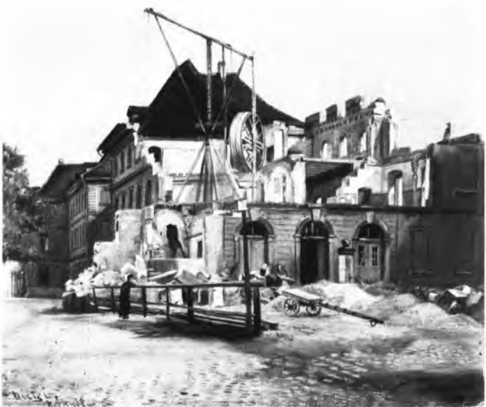
Abb. 12. Beginn der Abbrucharbeiten am Westflügel des Inselspitals 1), 1888. Ölbild von Hans Dietzi (1864–1929).
