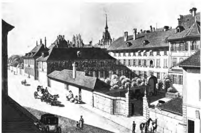
Abb. 11. Inselgasse (Kochergasse), um 1830. Links im Hintergrund das Operatorhaus, rechts das Marcuard-Haus 2). Aquarell von Franz Schmid (1796–1851).
