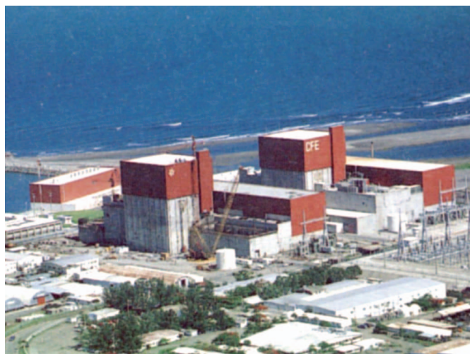
La nucleoelectricidad de Laguna Verde tiene una capacidad efectiva instalada de 1,360 megavatios, que representa el 3 por ciento de la capacidad efectiva total de generación de la CFE.
