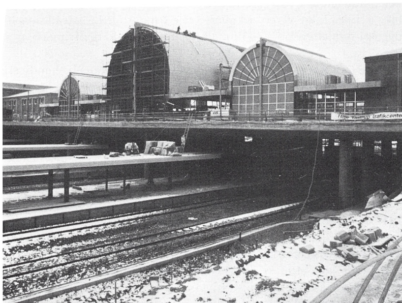
Hvælvingerne på Høje Taastrups nye banegård er bærende stalkonstruktioner beklædt med rustfrit stal. DSB, fotoarkivet.
