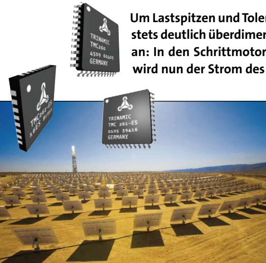
Bild 1: Heliostat – 15m 2 Spiegelfläche werden von zwei kleinen Schrittmotoren präzise nachgeführt. (Bild mit freundlicher Genehmigung der Brightsource Energy)
