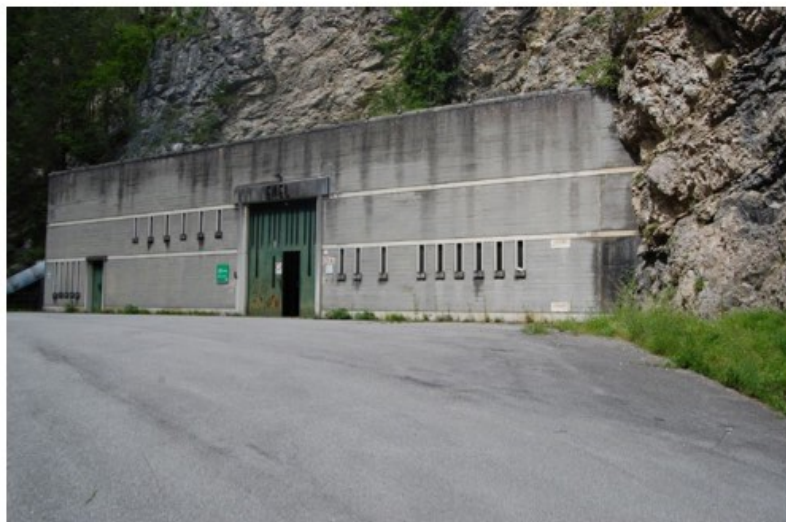
Centrale idroelettrica Pontesei, Forno di Zoldo (BL), progetto: ing. Carlo Semenza, arch. Ignazio Gardella, committente: Sade. Per gentile concessione di Enel
