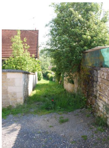
Mur de la rue du Chevalier
