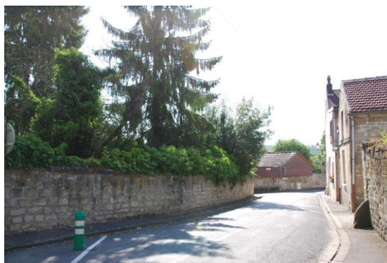
Mur de la rue Saint-Martin
