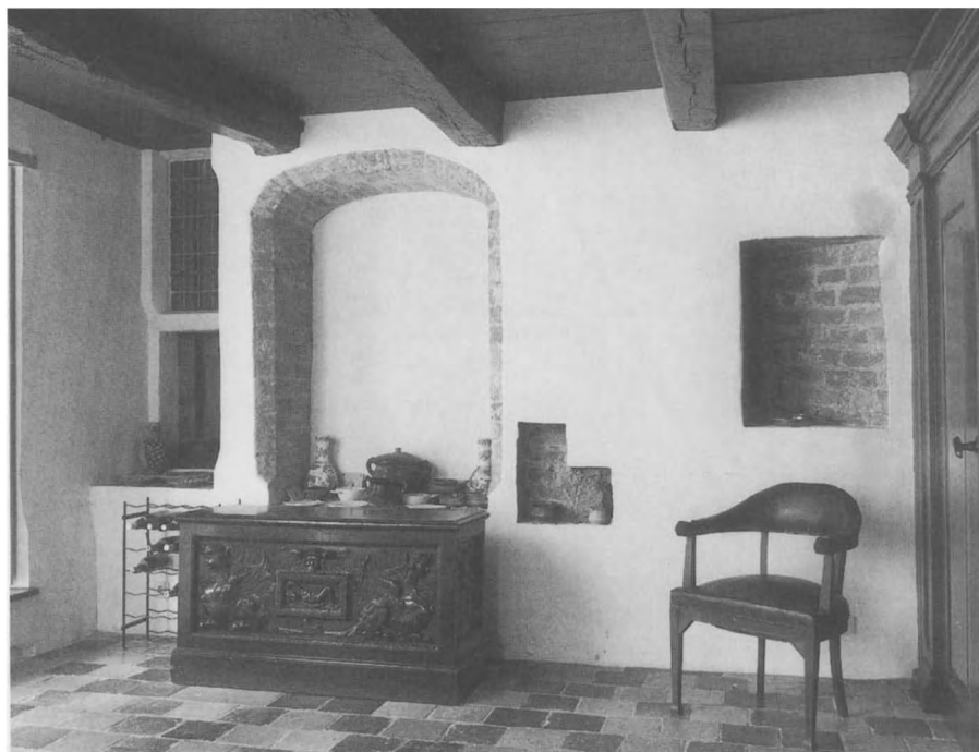
29 Overzicht zuidwand in 1989. Onder het venster in de oostelijke wand is de hoogte van de oudere vloer in zicht gebleven. In de hoek het venster uit 1634. Links van het midden de grote muurnis uit ca. 1500. Rechts daarvan een piscina? Geheel rechts een smal venster met scheve zijanten (foto RDMZ, 1989).
