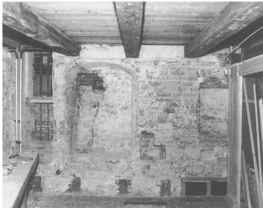
28 De zuidwand van de opkamer na ontleistering. Boven: de dendrochronologisch op ca. 1500 gedateerde balklaag. Beneden keldergewelven uit 1634. Daar boven de balkgaten van een oudere houten vloer. De bedstedenwand rechts stamt uit de 18de eeuw (foto Liturgisch Instituut Rijksuniversiteit Groningen).
