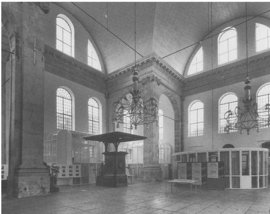
5 Amsterdam, Oosterkerk. Interieur na de verbouwing. (foto RDMZ, 1987).
