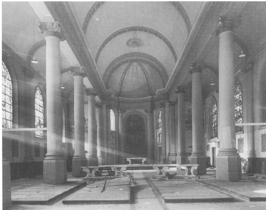
13 Gorinchem, H. Nic. Pieck. Interieur voor de verbouwing (foto RDMZ, 1982).
