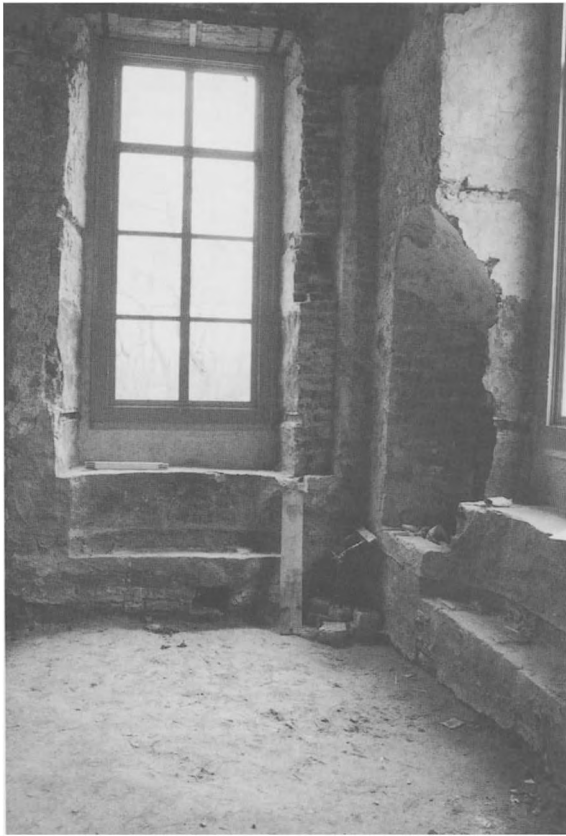
19 Noordwesthoek van de zaal. Boven het venster: een houten latei uit 18de eeuw. Rechts van het venster: muurdam uit 1634 ter versmalling van de breedte van ca. 1500. Onder het venster: uitholling voor de vensterbank van 1879. Rechts de noordmuur, met oorspronkelijk venster. Beneden de lemen vloer waarop de haardplaatsen werden aangetroffen (foto W.J. Berghuis, 1989).
