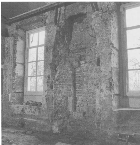
17 Overzicht westelijke wand na de ontmanteling en na het herstel van vensters en kozijnen. Links: dagkant met vellingkant van brede vensternis uit ca. 1500, ten behoeve van venster uit 1634 eenzijdig versmald. Midden: in het metselwerk uitgekapte schoorsteennis, met dichtgezet oorspronkelijk venster (foto RDMZ, 1989).
