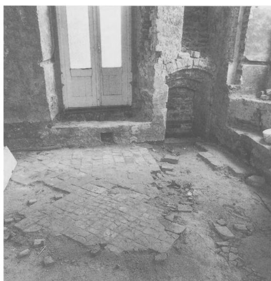
18 Rest van oude vloer in westelijk deel van de zaal. Deze vloer behoort bij de schouw van ca. 1500 en ligt ca. 10 cm boven de lemenvloer waarop de haardplaatsen werden aange troffen (foto RDMZ, 1989).
