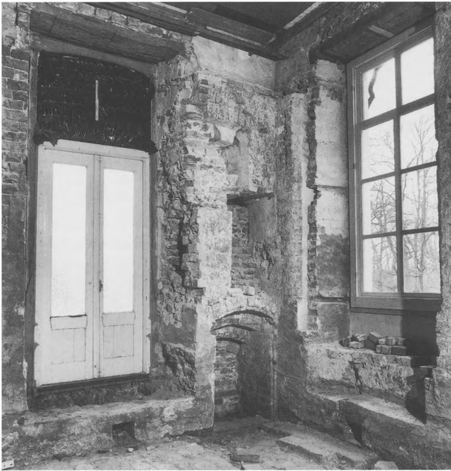
15 Zuidwesthoek van de zaal. Boven: Verdunning muurwerk bij vloerniveau van 1634. Daaronder deel van een oorspronkelijke segmentboognis voor toegang naar de opkamer in de zuidelijke aanbouw, dichtgezet in 1465? Lager: ingehakte nis, waarvan de linkerzijkant in de vulling van de oorspronkelijke deur werd gemetseld. Beneden: ingebroken doorgang naar kelder in zuidelijke aanbouw, met getrapte en afgeschuinde segmentboogjes en luikspinning. Rechts: venster in westgevel (foto RDMZ, 1989).
