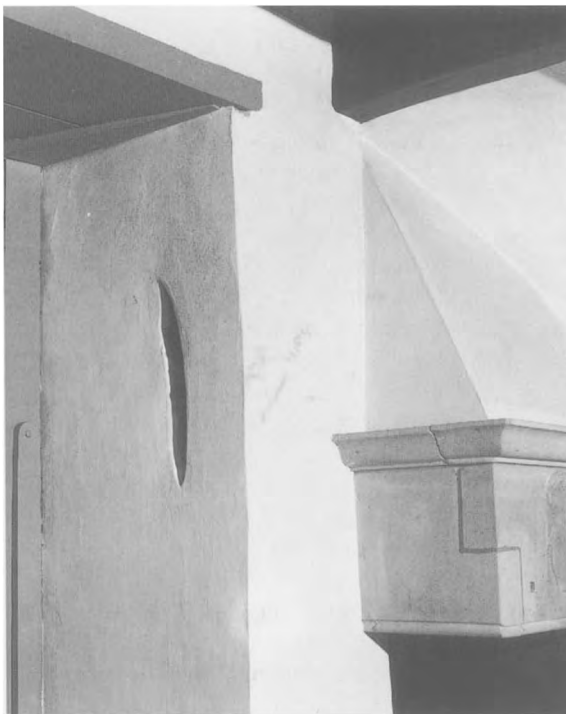
26 Rechterzijde van het venster links van de schouw. De achterzijde van een oudere stookplaats is in zicht gelaten. Rechts de gereconstrueerde schouwkap (foto RDMZ, 1989).
