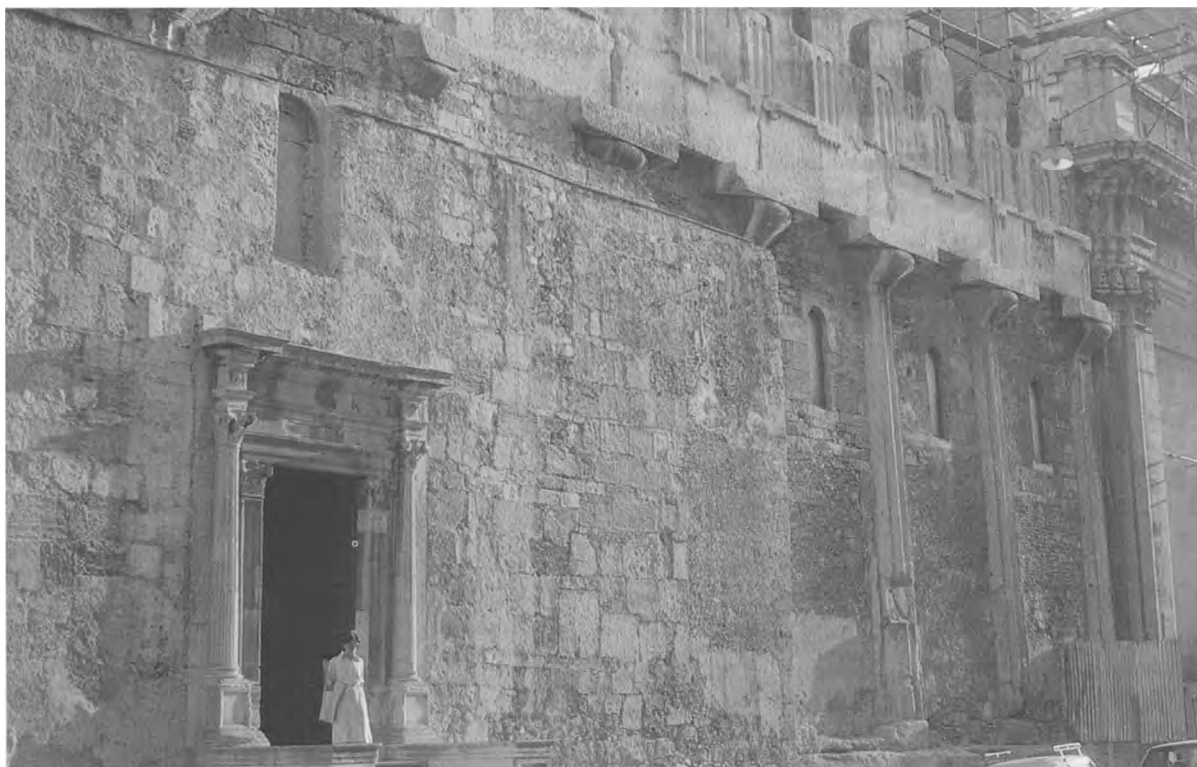
1 Syracuse, Noordwand van de kathedraal (foto A. de Vries).
