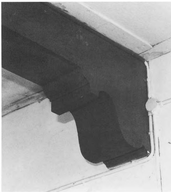
4 Balkconsole, 1ste verdieping nr. 75 (foto RDMZ, 1989).
