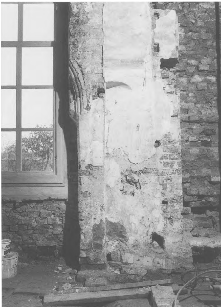
23 Muurpenant van de noordwand. Geboorte van de later ingebrachte gotische deurnis, met aanzetsteen van de segmentboog boven de deur en met resten van rode kleurstof. In het pleisterwerk, de aftekening van de scheidingsmuur met het voorhuis (XVII B?). Rechts daarvan een ingehakte uitholling ten behoeve van deur, met aan de onderzijde een 17de-eeuwse tegelplint en enkele uitgevallen stenen bij de verticale muurkokers. Rechts: de linkerkant van de nis van het lage spleetvormige venster, dat later naar boventoe werd opgehakt. In de vloer de fundering voor de voorkant van het 18de-eeuwse bedsteeblok (foto RDMZ, 1989).
