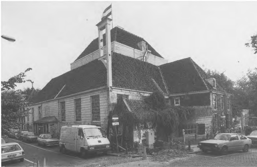
1 De Amstelkerk vanuit het noordwesten, vóór de restauratie (foto RDMZ, 1968).
