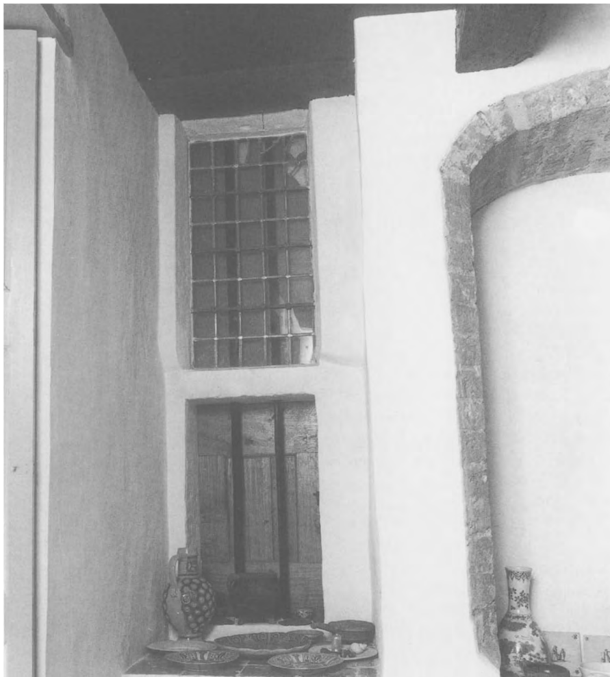
26 Rechterzijde van het venster links van de schouw. De achterzijde van een oudere stookplaats is in zicht gelaten. Rechts de gereconstrueerde schouwkap (foto RDMZ, 1989).
