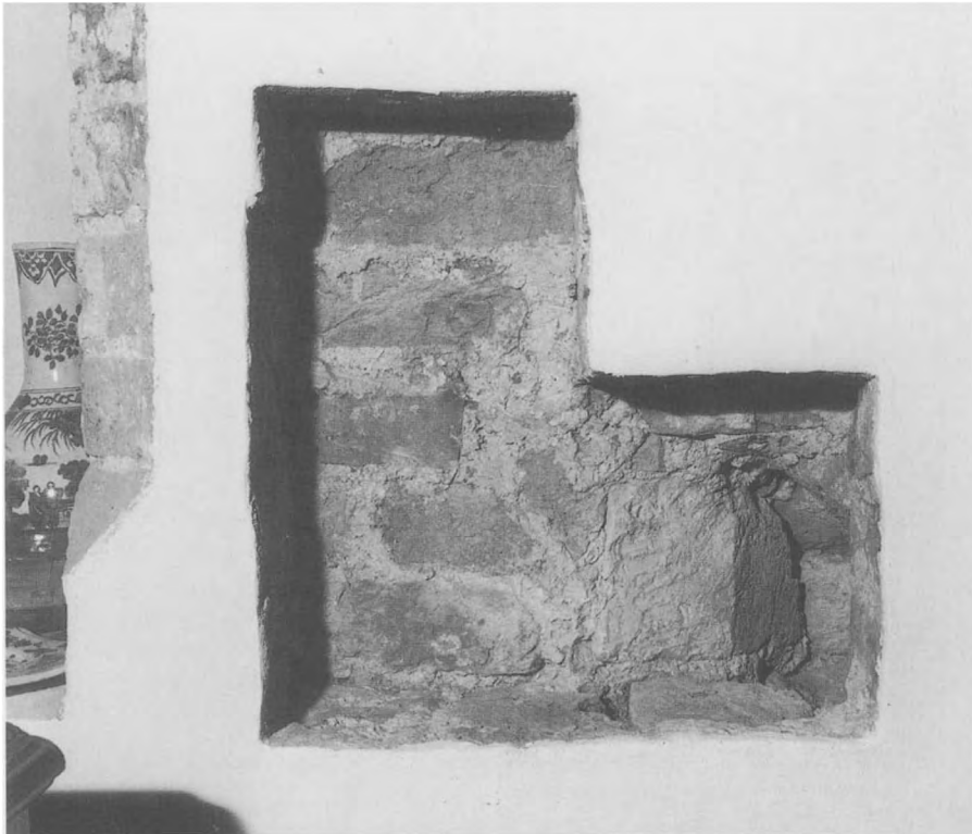
30 Asymetrische muurnis. Aan de rechterzijde is een uitgietsgat van baksteen. Dit loopt in de muur schuin omlaag en buigt daarna naar buiten (foto RDMZ, 1989).
