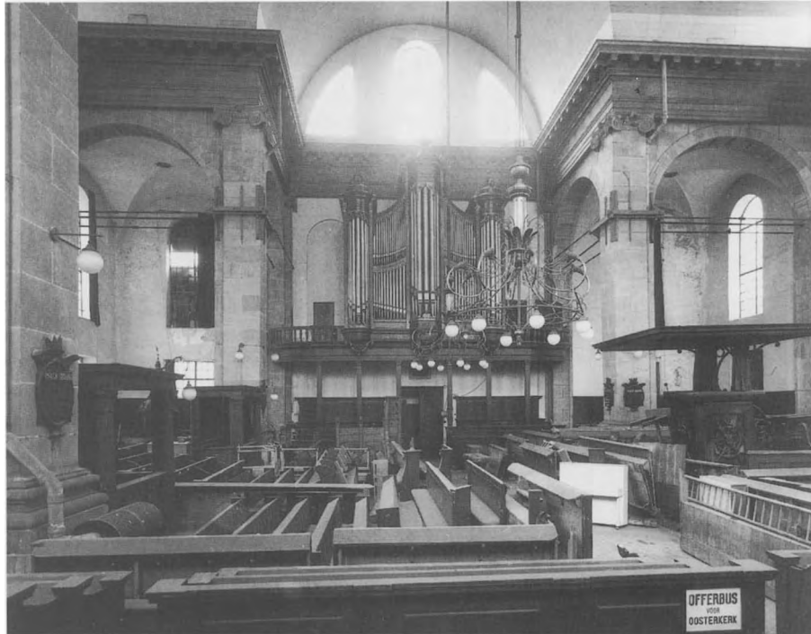
4 Amsterdam, Oosterkerk. Interieuropname uit 1965 (foto Bureau Monumenten- zorg Amsterdam).
