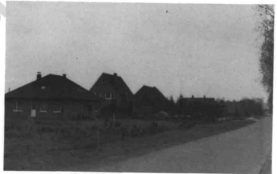
Straße „Am Düker“, Aufnahme von April 1979.
