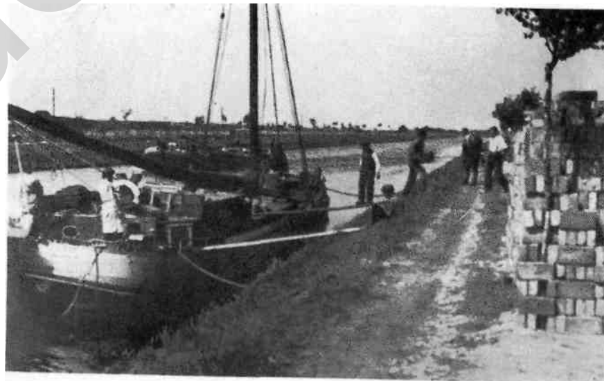
(Archiv: Oldenb. Siedlungsamt) Heranschaffung von Baumaterial per Schiff
