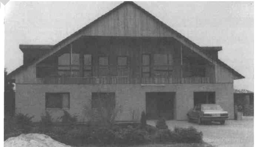
Werkstatt und Lagerhalle der Fa. Everts, äußerlich dem Wohngebiet angemessen.
