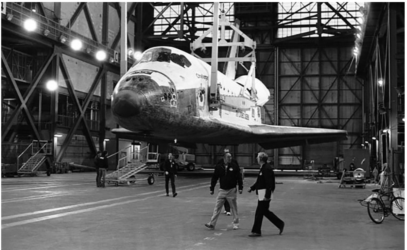
Challenger est sur le point d'être redressée afin d'être hissée sur le réservoir central de couleur brun rouille.
