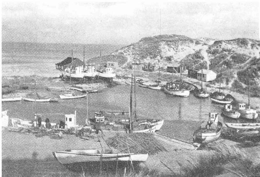
Hvide Sande. Det hører til sjældenhederne at man kan vise billeder af en bebyggelse fra dens grundlæggelses- og navngivningstidspunkt. Billedet her af Hvide Sande er kun få år yngre end by- og havneanlægget. Det er fiskekutterne og de bevoksede klitter frem for det hvide sand der dominerer billedet. (Foto: Sv. Türck i Danmark før og nu.)
