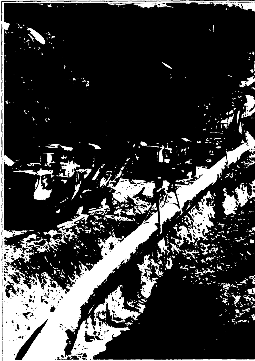
Fotografia n° 37 : Posa della condotta nello scavo.
