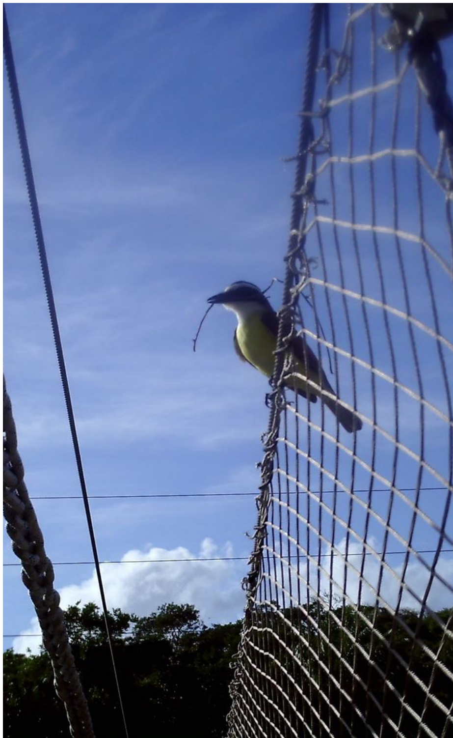
Passagem de fauna na CLN |
