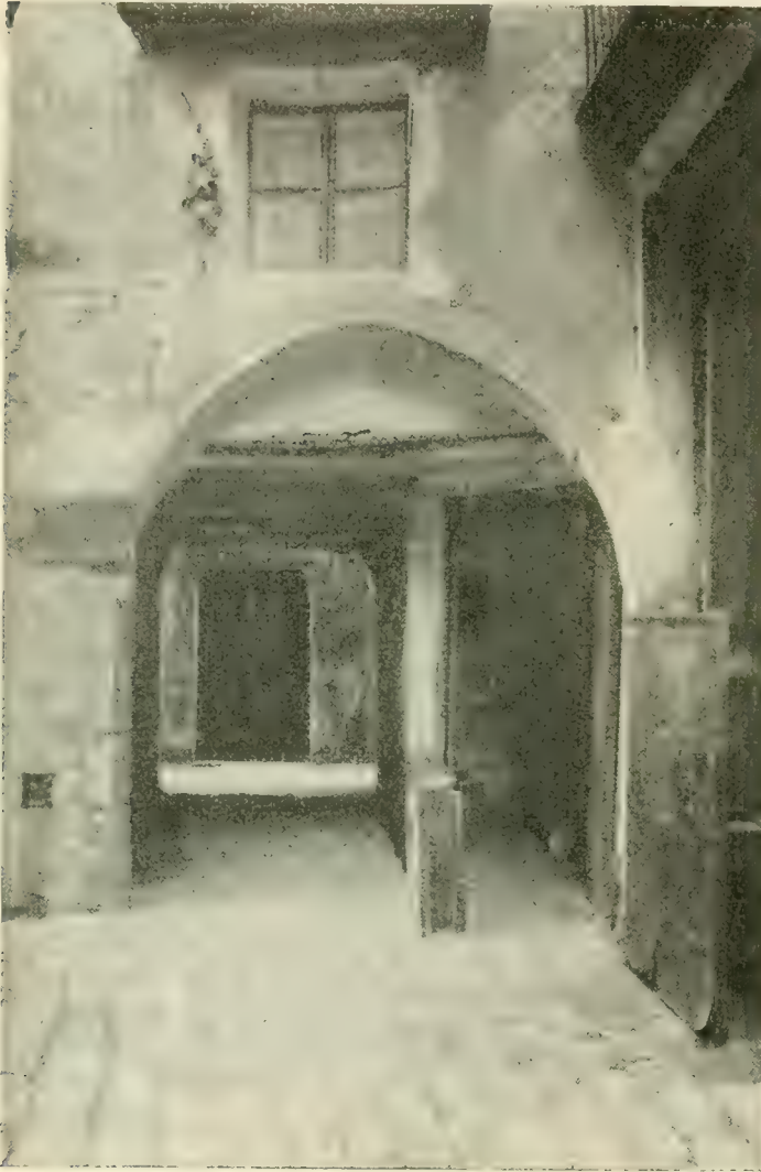
Interessant arch que comunicava lo carrer de Jupí ab lo de Mallà, derrocat en 1909, al obrir la via Layetana
