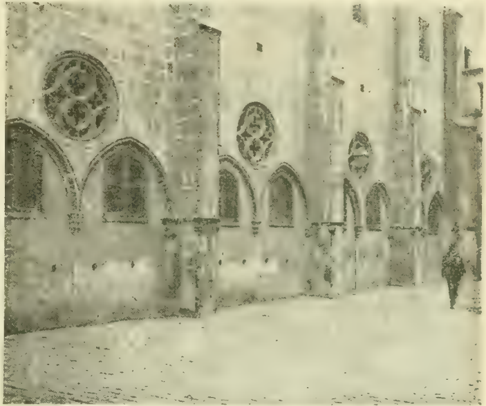
Detalls arquitectònics que han restat de la vella esglesia
