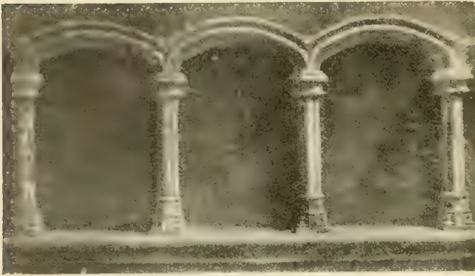
Galeria interior apareguda en les obres restauradores del 1910
