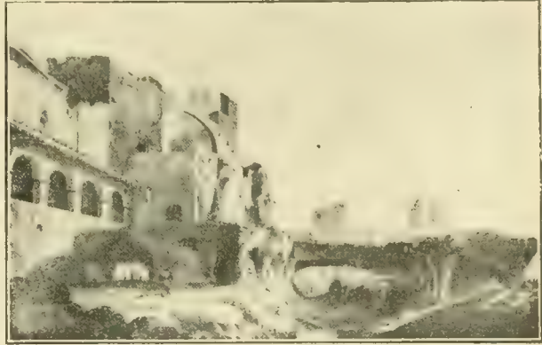
Derrocament de la vella construcció en 1859
