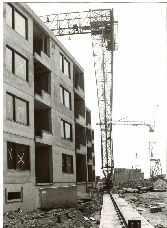
Abbildung 26: Im Vordergrund Portalkran, im Hintergrund Turmdrehkran
