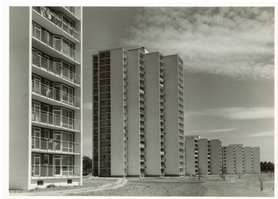
Abbildung 6: Wohngebäude in Edigheim, Punkthochhäuser errichtet in Feidner-Kastenbauweise
