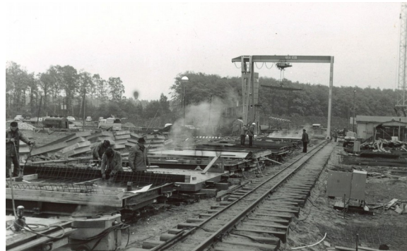
Abbildung 21: Herstellung von Deckenelementen auf der Baustelle
