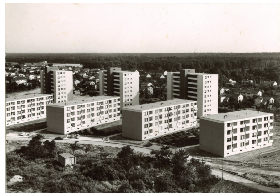
Abbildung 9: Wohnhäuser in der Goldstein-Siedlung Frankfurt/Main, errichtet in Großtafelbauweise System Holzmann-Coignet
