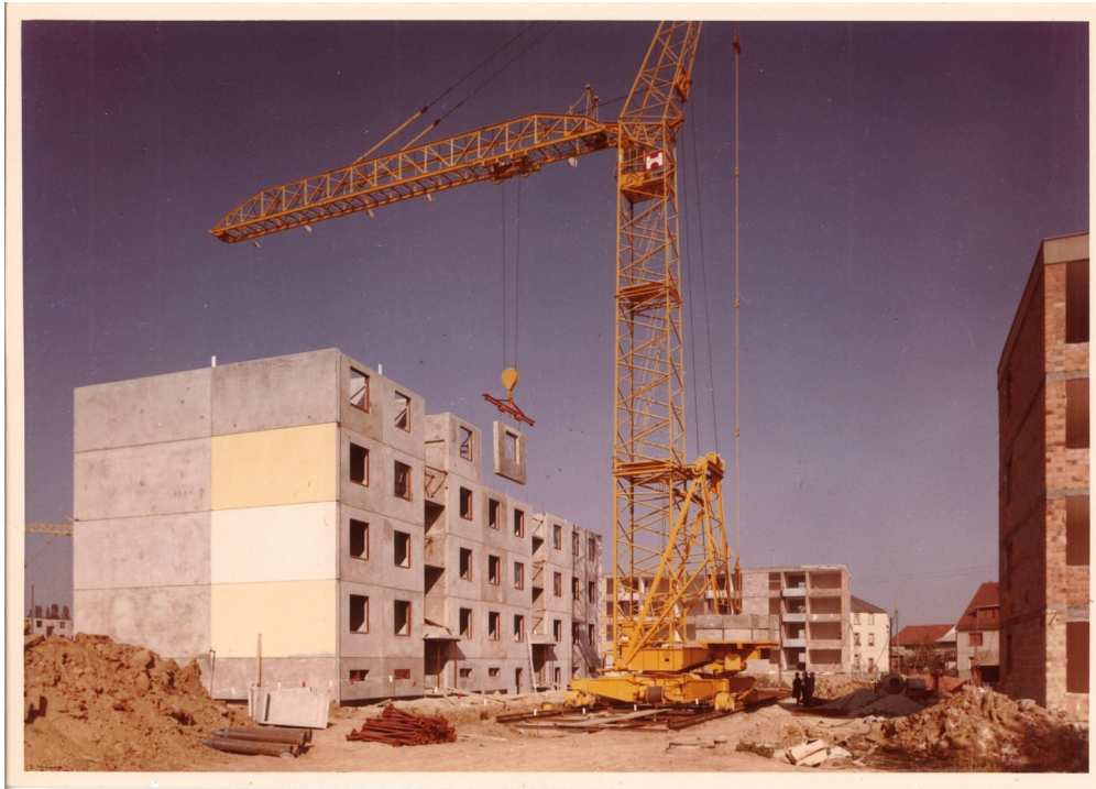
Abbildung 31: Einbau einer Wandtafel
