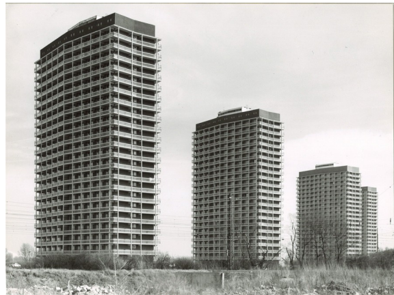
Abbildung 5: Wohngebäude der Siedlung Froschlache in Ludwigschafen am Rhein, Punkthochhäuser errichtet in Feidner-Kastenbauweise
