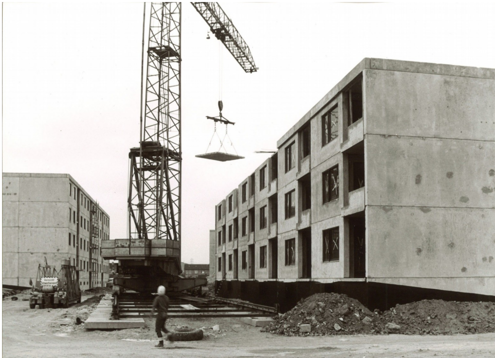
Abbildung 30: Einbau einer Deckentafel
