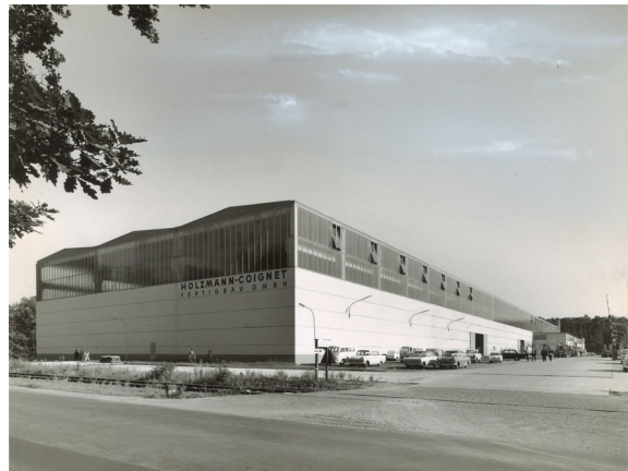
Abbildung 10: Fertigteilwerk der Holzmann-Coignet Fertigbau GmbH in Neu-Isenburg
