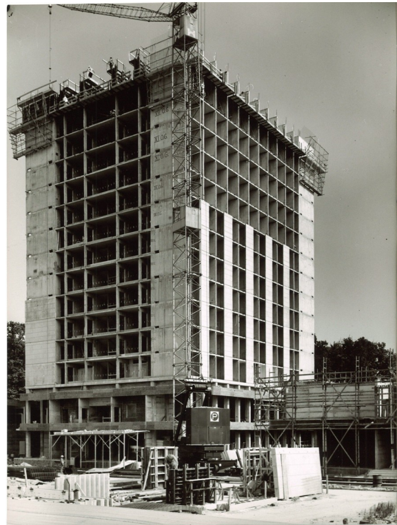
Abbildung 7: Bau der Post-Ingenieurschule in Dieburg, Punkthochhaus errichtet in Schottenbauweise
