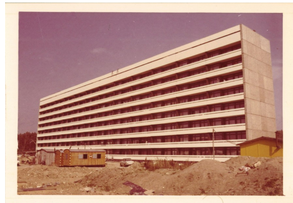
Abbildung 8: Wohngebäude in Detmerode, Scheibenhaus errichtet in Großtafelbauweise System Holzmann-Skarne
