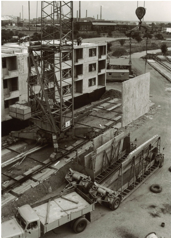
Abbildung 27: Abladen der Tafeln mittels Turmdrehkran
