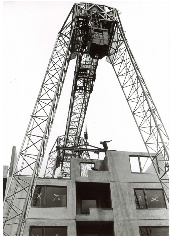
Abbildung 28: Einbau einer Wandtafel mittels Portalkran
