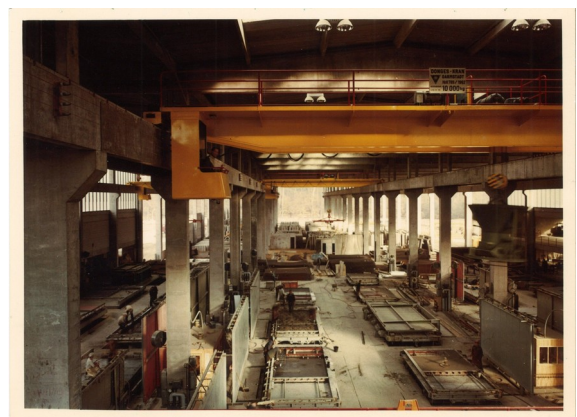
Abbildung 13: Innenansicht der Fertigungshalle, Neu-Isenburg
