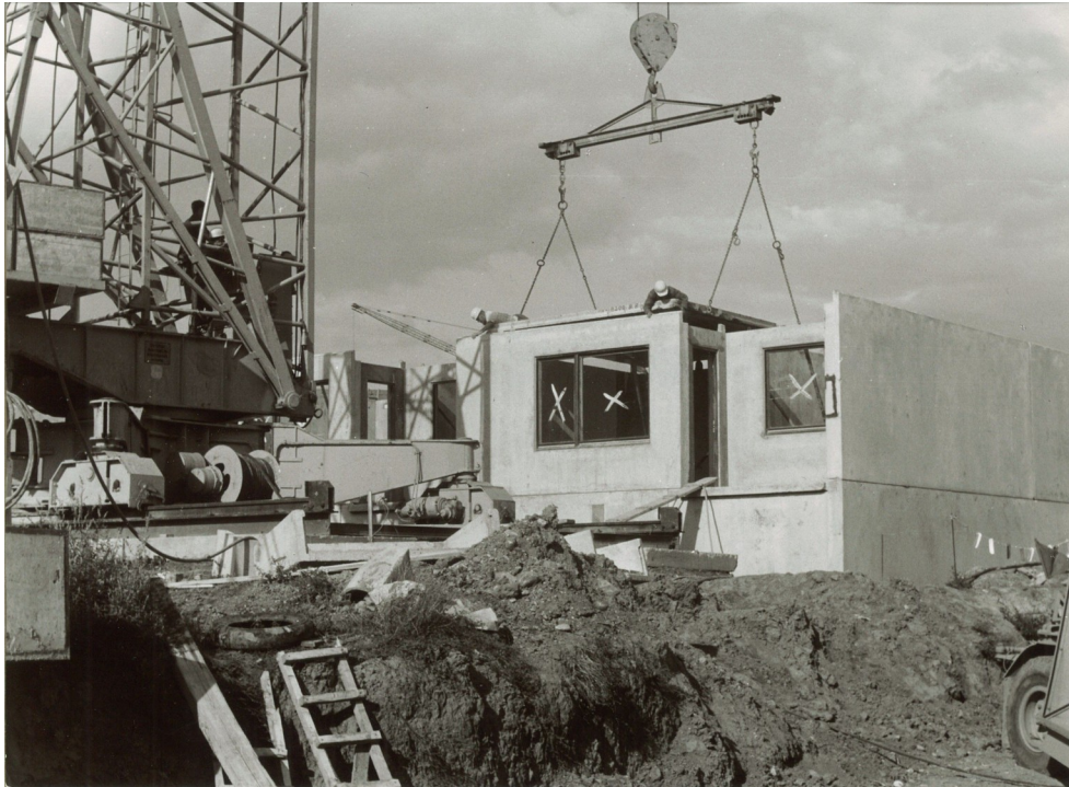
Abbildung 29: Einbau einer Deckentafel
