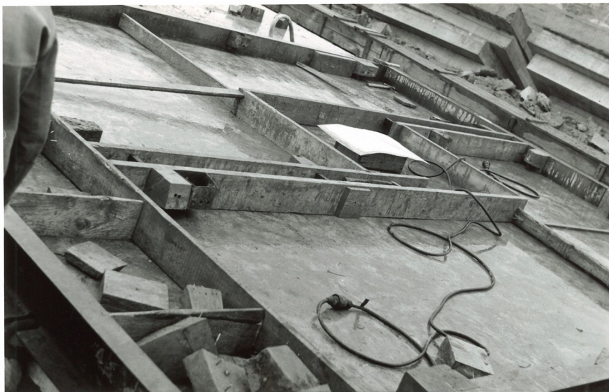
Abbildung 22: Deckenschalungen aus Betonmatrizen, Randschalungen aus Stahl und Zwischenabstellungen aus Schalholz
