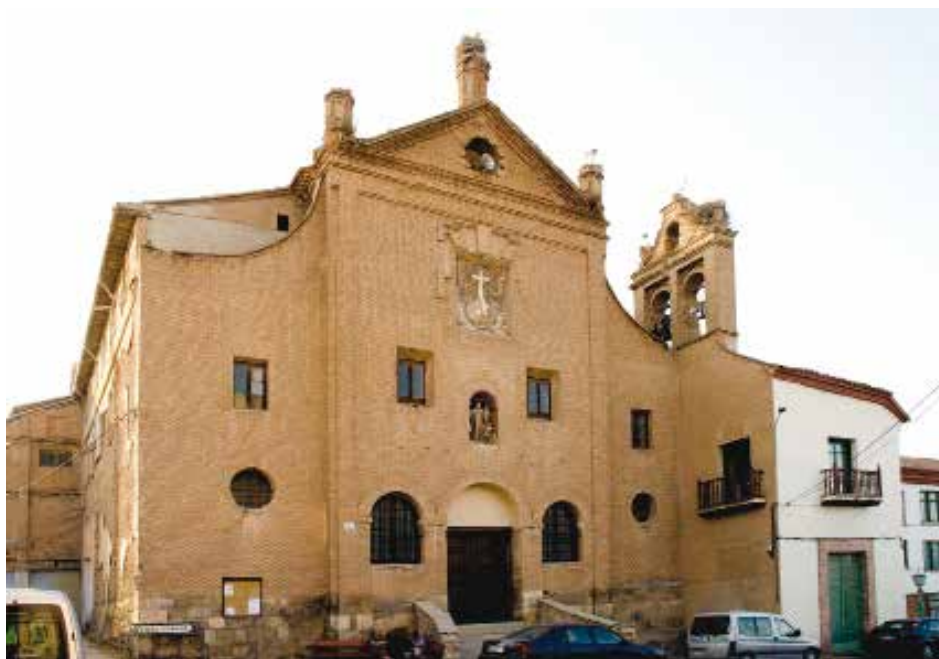
FIGURA 7. Fachada de la iglesia del convento de carmelitas descalzos de Santa Teresa de Jesús. Foto: Rafael Lapuente.
