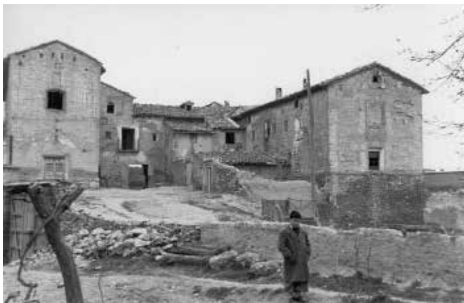
FIGURA 2. Imagen retrospectiva del convento de San José poco antes de su demolición.
