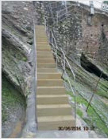
Figura 7.2. Escaleras reconstruidas (30-04-2014). www.miteco.gob.es
