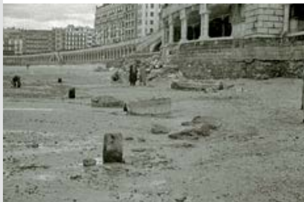
Figura 3.3. Pilotes de madera y estructuras del antiguo balneario de El Perlón (1951), desmantelado en 1906. www.kutxateka.eus
