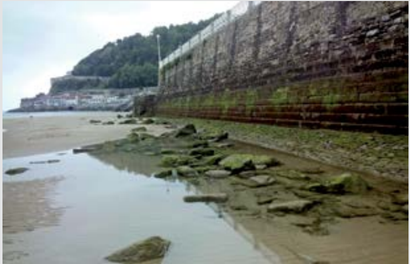
Figura 2.1. Afloramiento de escollera (09-05-2015). Los bloques de silliería de la base del muro guardamar datan de 1755. http://www.ingeba.org
