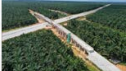
Pembinaan jambatan di Seksyen 7A (Kuala Selangor) Bridge construction at Seksyen 7A (Kuala Selangor)
