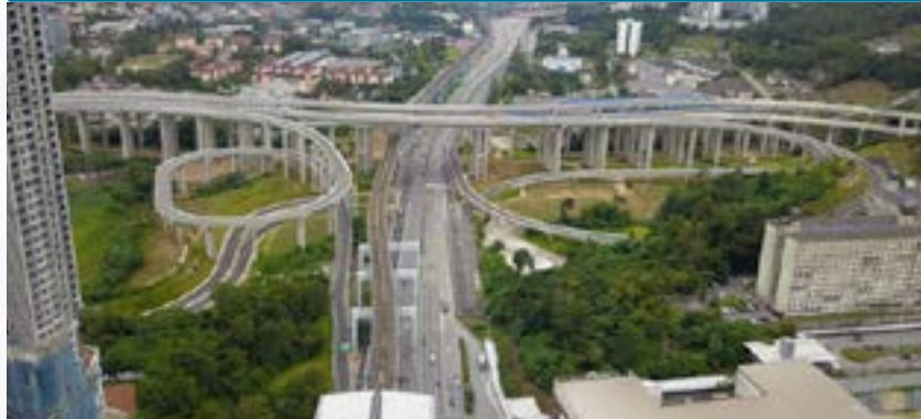
Persimpangan Bertingkat Cheras - Kajang (suaimuka dengan GRANDSAGA) Elevated Intersection Cheras - Kajang (meets with GRANDSAGA)
