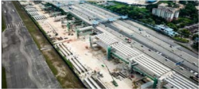
Kerja-kerja struktur di Seksyen 2 Bandar Malaysia (Lapangan Terbang Sungai Besi) Structural works in Bandar Malaysia Section 2 (Sungai Besi Airport)
