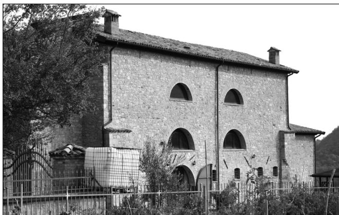
Fig. 4 – Chiesa Nuova ricostruita in località Villa Bassa (ora abitazione privata).
